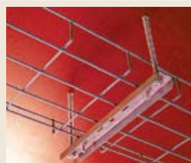
■ Подвес на шпильке с применением профиля ПП100
