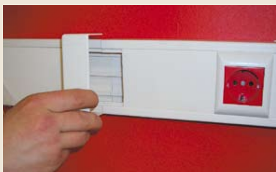
■ Установка соединения на стык производится защелкиванием
