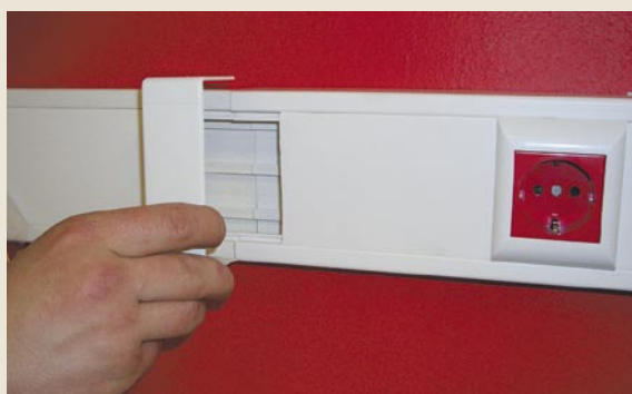
■ Установка соединения на стык производится защелкиванием
