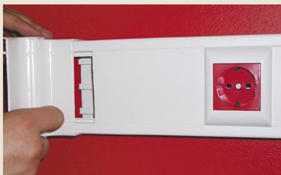
■ Установка внутреннего угла производится защелкиванием. Сдвиньте крышки короба в нужное положение до фиксации под накладкой угла
