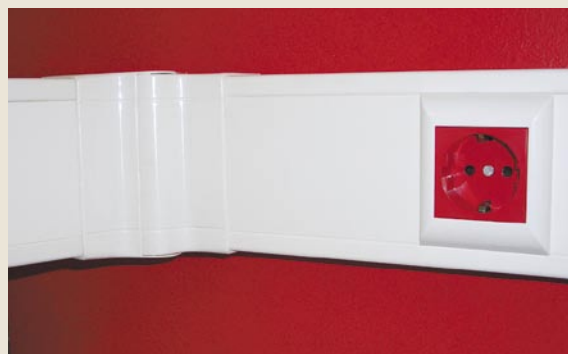
■ Установка внутреннего угла производится защелкиванием. Сдвиньте крышки короба в нужное положение до фиксации под накладкой угла
