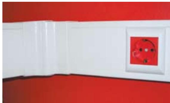
■ Установка внутреннего угла производится защелкиванием. Сдвиньте крышки короба в нужное положение до фиксации под накладкой угла
