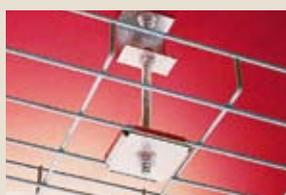
■ Подвес на шпильке с использованием ПППЛ и КППЛС
